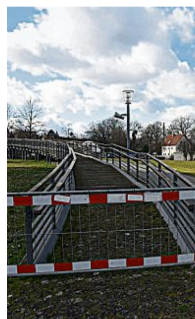
Schlossparkbrücke FOTO: H. KRIMMER
