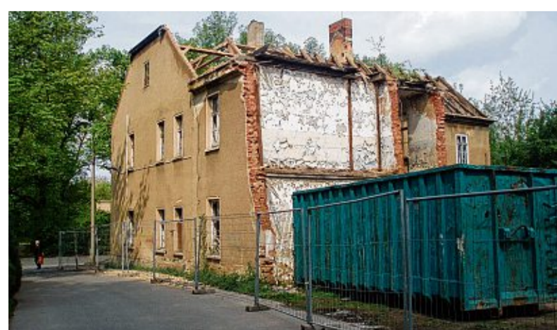
2010 wurde der älteste Teil des Krankenhauses abgerissen. FOTO: P. WITTIKA
