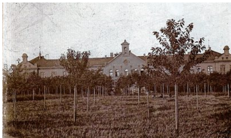
Am 29. Oktober 1890 wurde das Zeitzer Stadt Krankenhaus in der damaligen Linden- und heutigen Röntgenstraße feierlich eingeweiht. FOTO: ARCHIV WITTIKA
