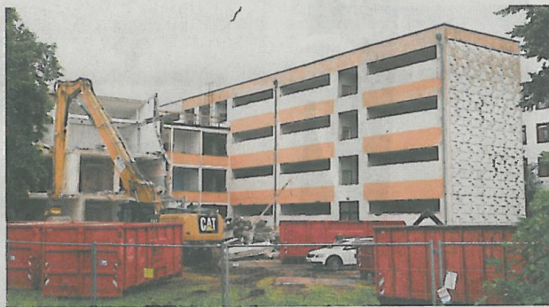
Das seit zehn Jahren verwaiste Gebäude der Gagarinschule wird abgerissen. Das Klinikum plant, die Fläche teils als Parkplatz zu nutzen. FOTO: TORSTEN BIEL
